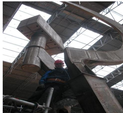
В 2009 г. в ходе реставрации сотрудники ООО «ТСЗП» провели работы по газотермическому напылению алюминием и цинком элементов металлоконструкции и крепежных площадок знаменитой скульптуры «Рабочий и Колхозница». Работы выполнялись как на месте производства металло-конструкций, так и на месте монтажа. Произведена защита металлизацией опорных балок, сварных швов, площадок болтовых соединений. Гарантийный срок службы покрытий превышает 40 лет.
